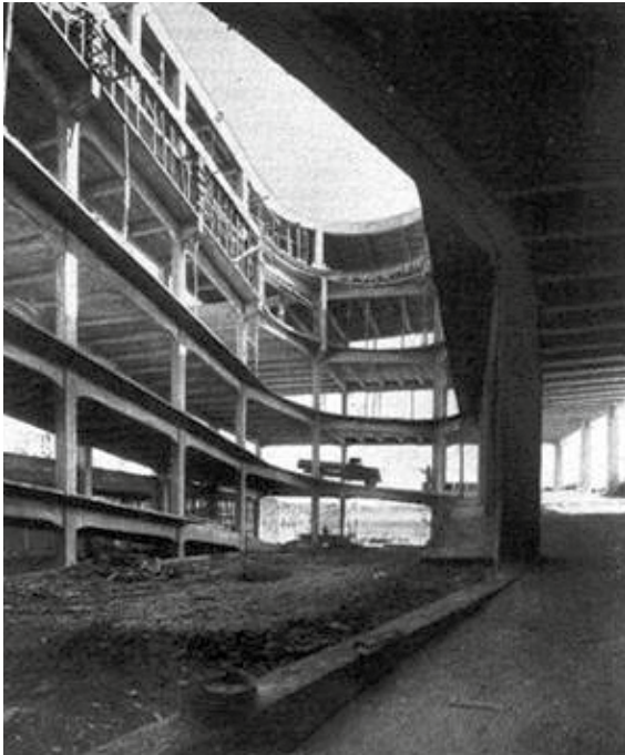
Detalle de la rampa durante la construcción
